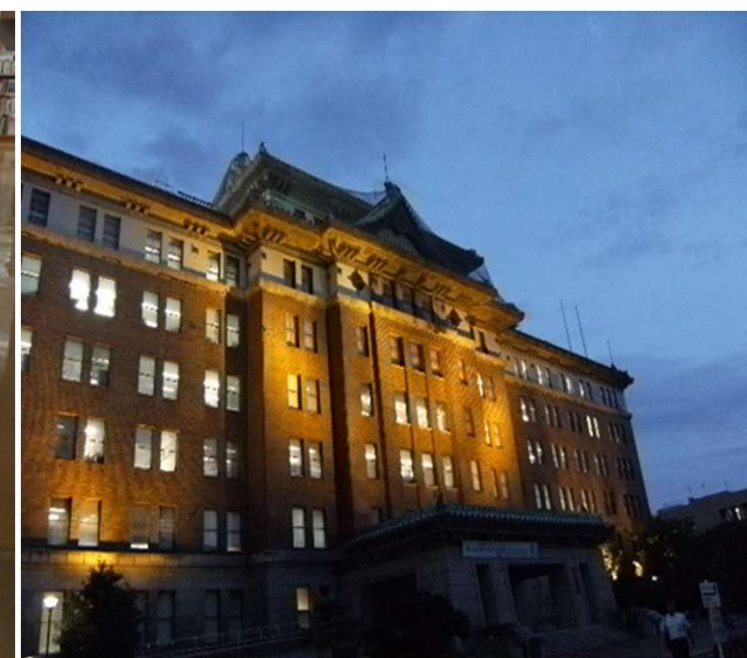
愛知県 (本庁舎ライトアップ)
